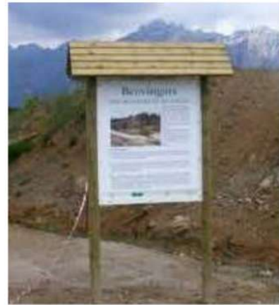
PANEL INFORMATIVO 3 m DE ALTURA EN MADERA DE PINO TRATADA AL ALUTOCLAVE NIVEL IV CON TEJADILLO MADERA DE LAMAS 1410x1160 mm Y PANEL CENTRAL DE CHAPA DE ACERO 1410x1000x3 mm
