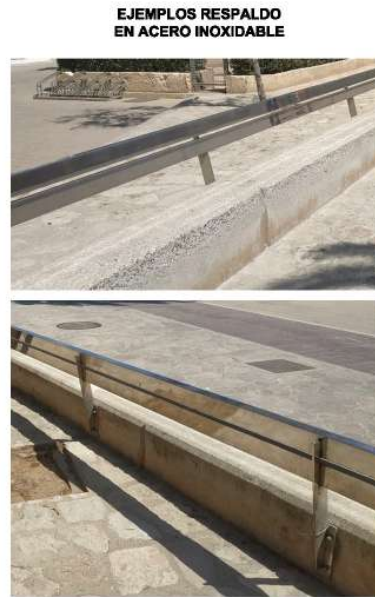
BANCO MEDIANTE PIEZAS DE MARÉS DE 45x45 cm Y 1 m DE LONGITUD CON RESPALDO
