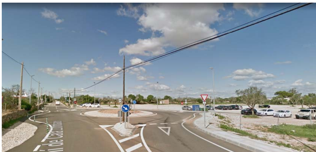
Situació actual de la rotonda executada i l'aparcament provisional fins a l'aprovació definitiva d'aquesta modificació.
